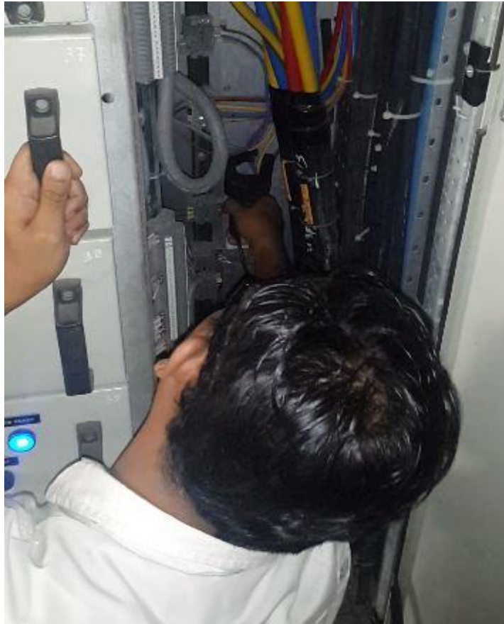
Gambar 3.4 Pengukuran arus R,S,T dengan probe MCSA
