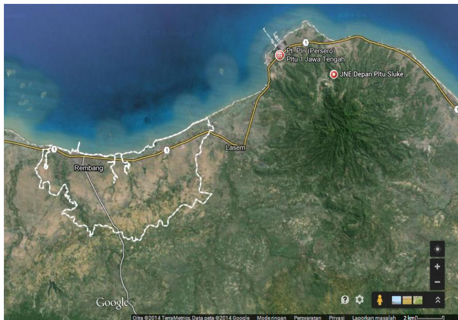
Gambar 3.1 Lokasi PT PJB UBJ O&M PLTU Rembang
