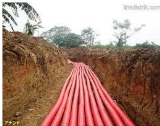
Gambar 2.2 Saluran Kabel Tegangan Mengengah Sumber : klipingbekasi – Wordpress.com
