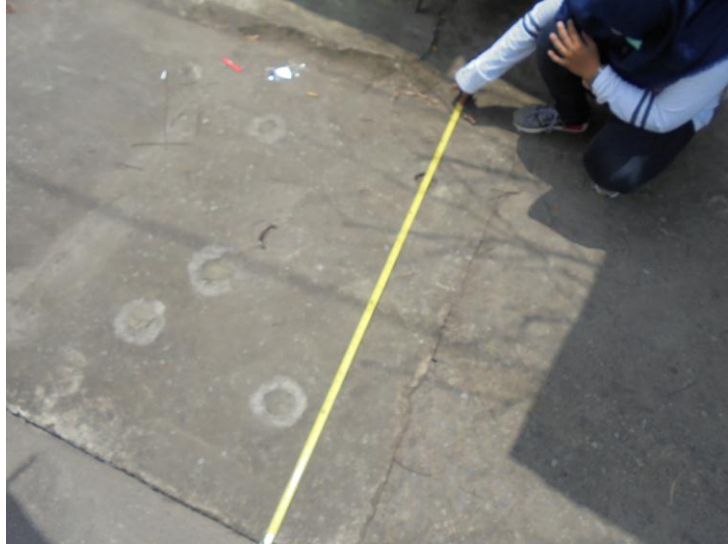
Gambar 4.12 Kondisi Saluran Drainase Sistem Tertutup
