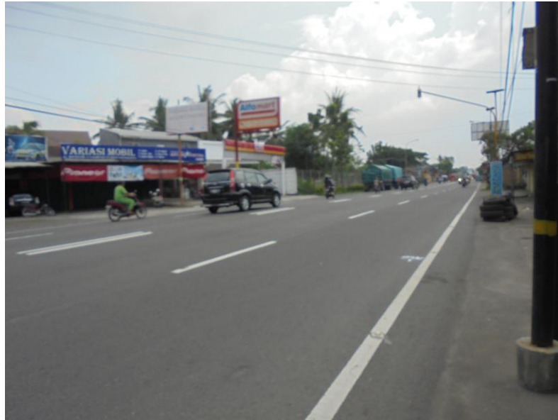
Gambar 5.15 Tidak Terdapat Pagar Penghalang Tabrakan
