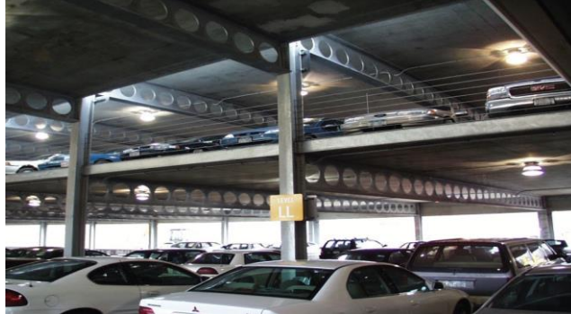
Gambar 3.9 Castella beam bukaan lingkaran pada area parkir (Sumber : AISC, 2016)
