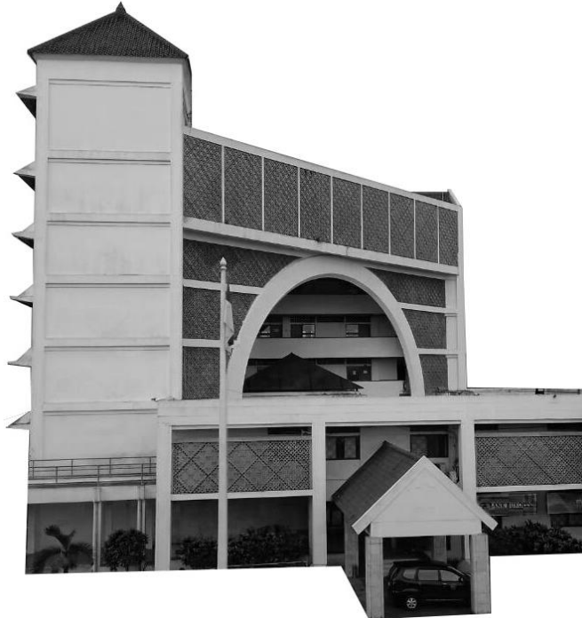
Gambar 4.3 Tampak Depan Bangunan
