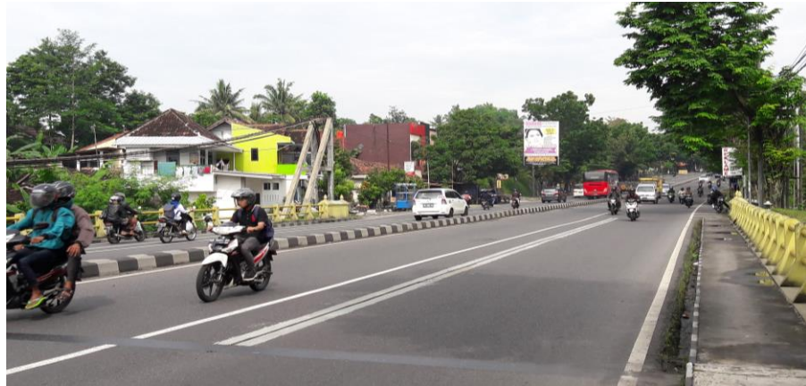
Gambar 5.10. Kondisi jembatan pada KM 12.
