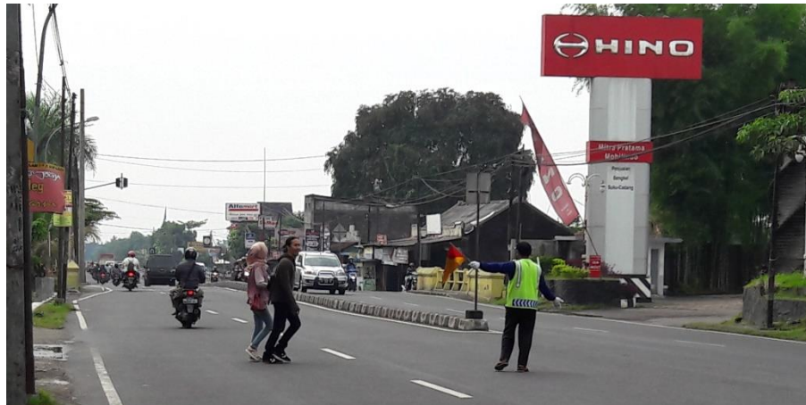
Gambar 5.7. Tidak ada nya rambu pejalan kaki dan fasilitas penyeberangan pejalan kaki (Zebra Cross) pada 14.5.
