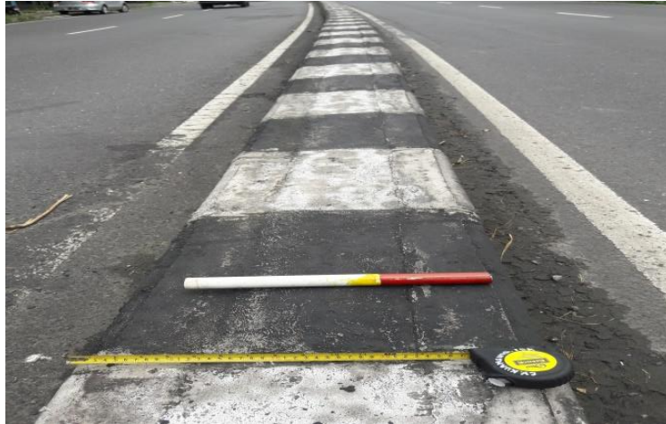
Gambar.5.1. Median Jalan pada ruas Yogyakarta - Magelang KM 11 sampai dengan KM 15
