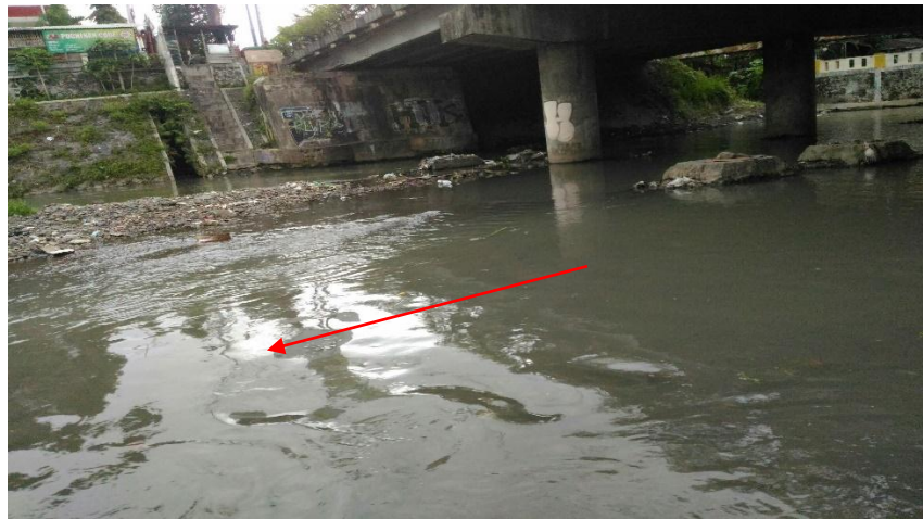
Gambar 5.5 Alur sungai disegmen Jembatan Tungkak
