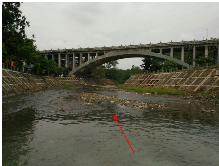
Gambar 5.1 Alur sungai di Jembatan Sarjito
