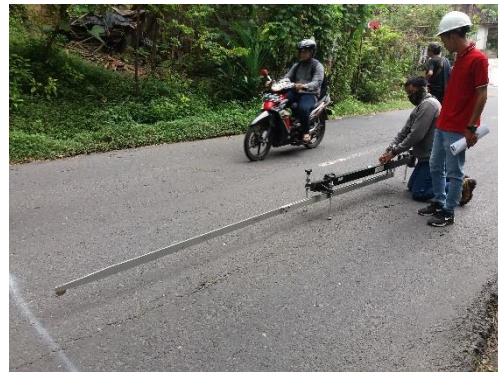
e. Pengaturan Kaki Alat Benkleman Beam
