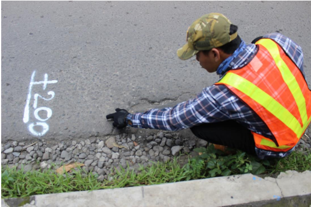
Gambar 5 Membuat tanda Stationing
