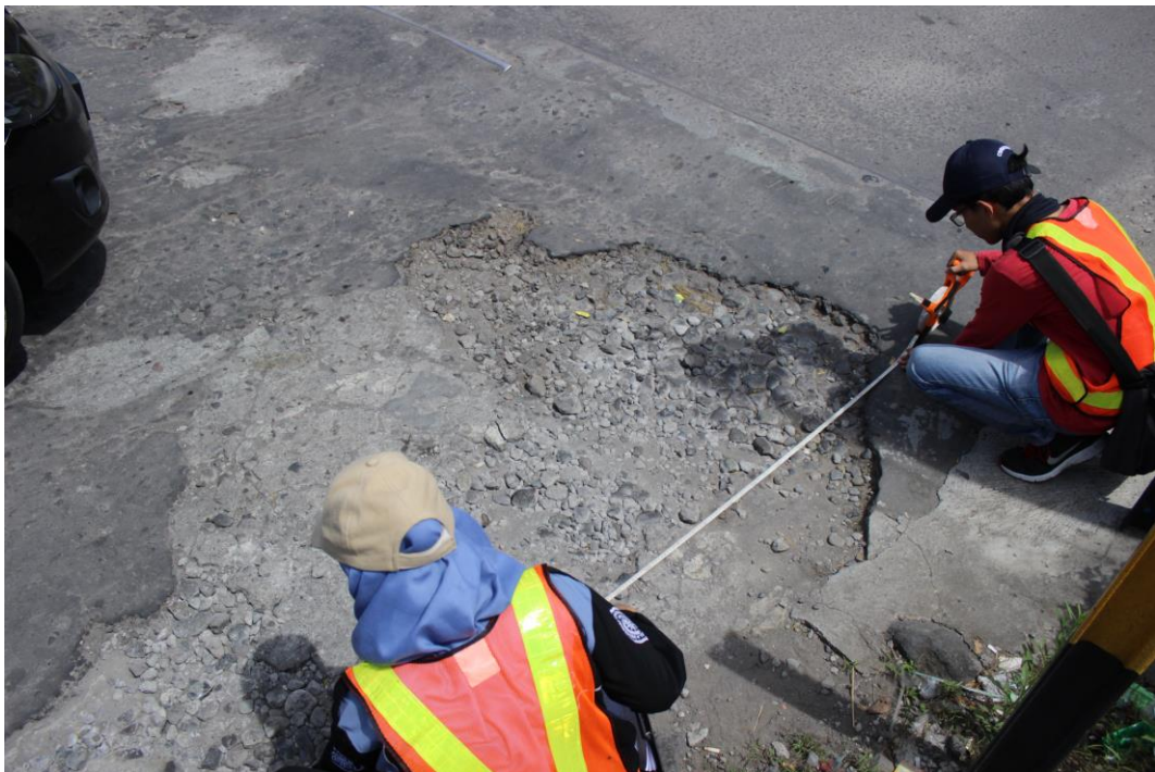
Gambar 6 Melakukan pengukuran luas kerusakan
