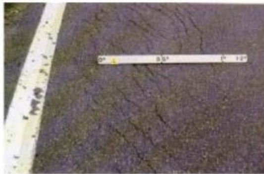
Gambar 16 Retak Patah Slip
