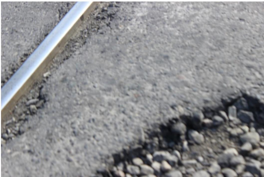
Gambar 2 Kondisi kerusakan perpotongan rel
