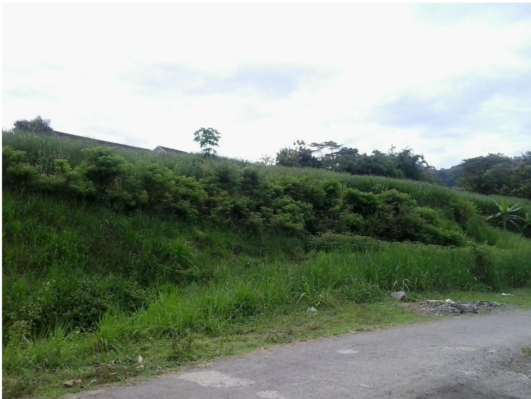
Gambar A.2 Kondisi lokasi tampak dari sisi jalan
