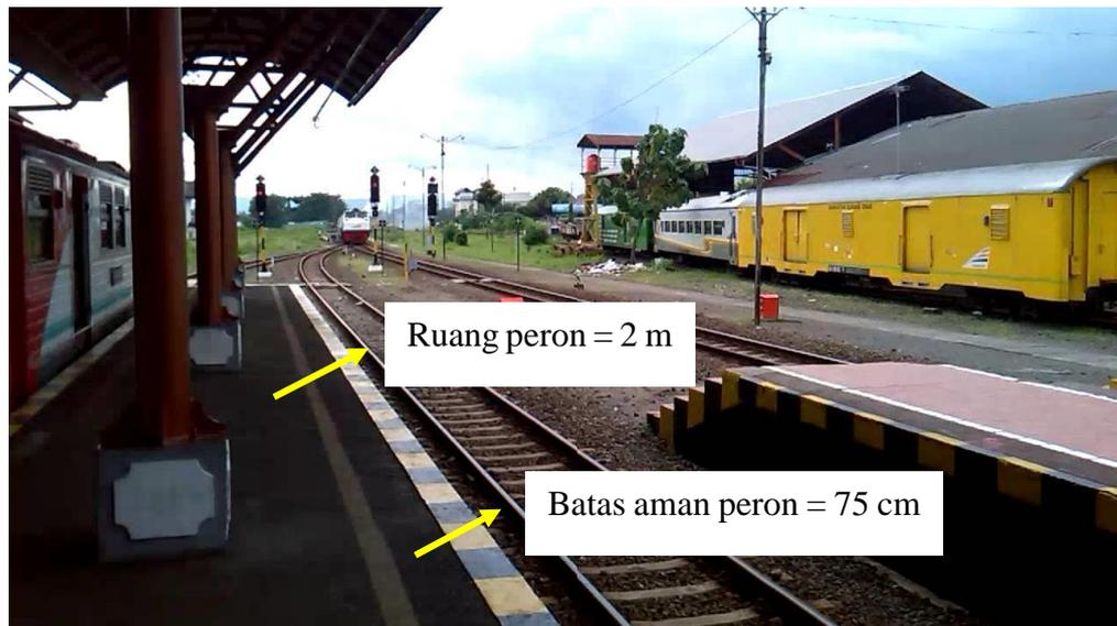
**Gambar 5. 10** Ilustrasi konstruksi peron di Stasiun Betung
