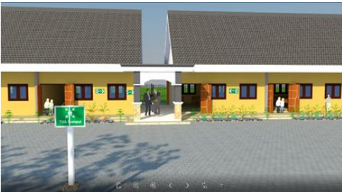
Gambar 10. Tampak depan bangunan bagian dilatasi
