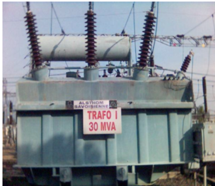
Gambar 2.7 Trafo Tenaga
