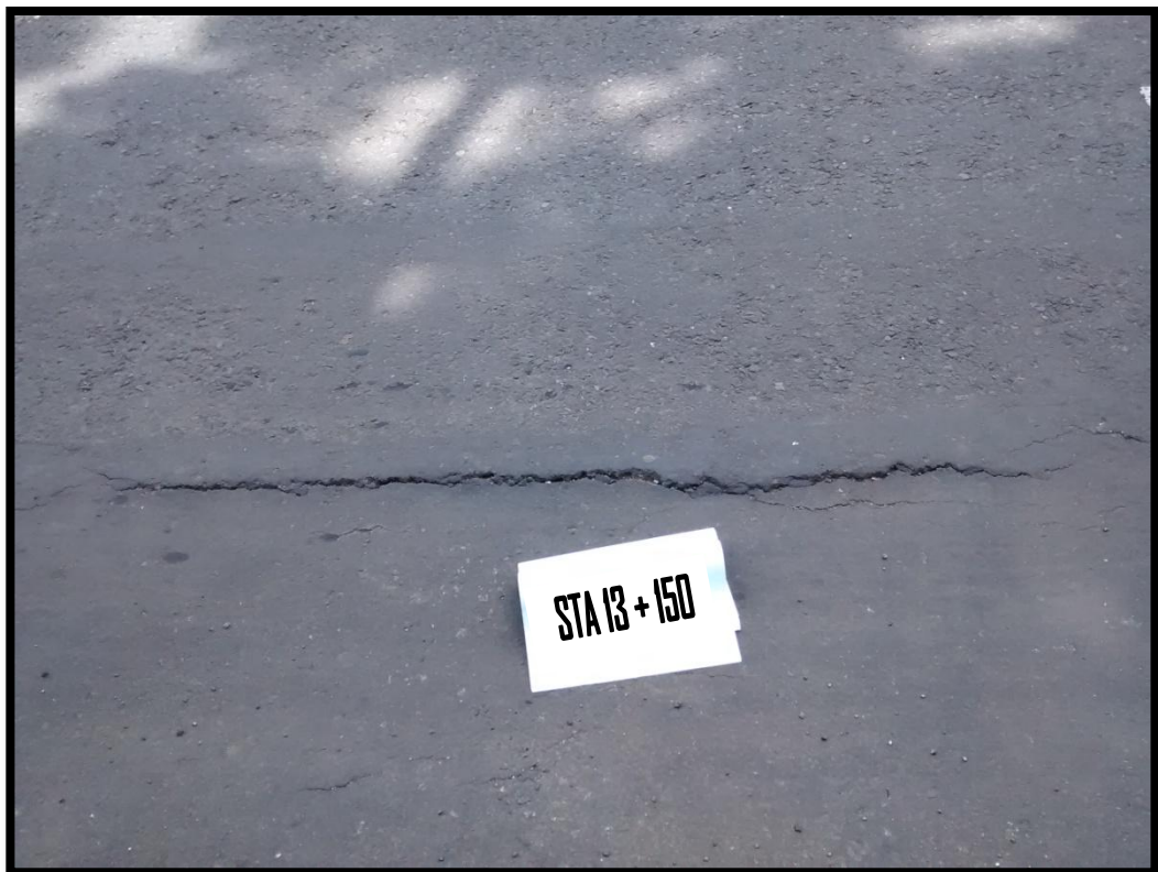
Gambar 6. Retak memanjang/melintang.
