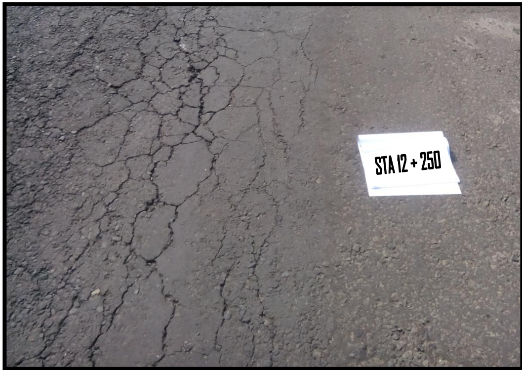
Gambar 1. Retak kulit buaya.
