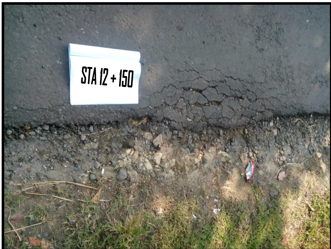
Gambar 4. Retak pinggir.
