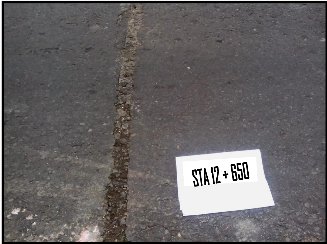
Gambar 5. Retak sambung.
