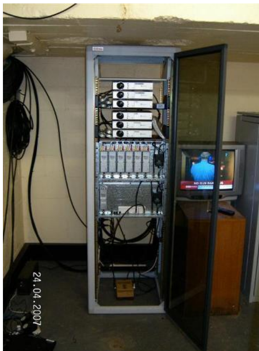
Gambar 2.40. Perangkat Head End MATV di Dalam Rak
