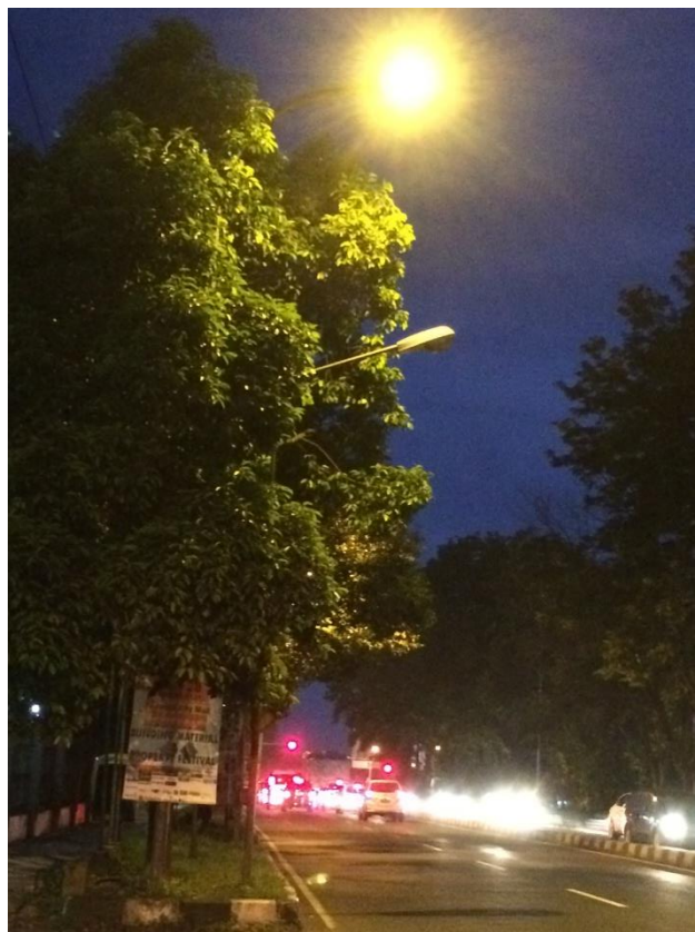
Gambar 5.20 Kondisi Lampu Penerang Jalan yang Tidak Berfungsi
