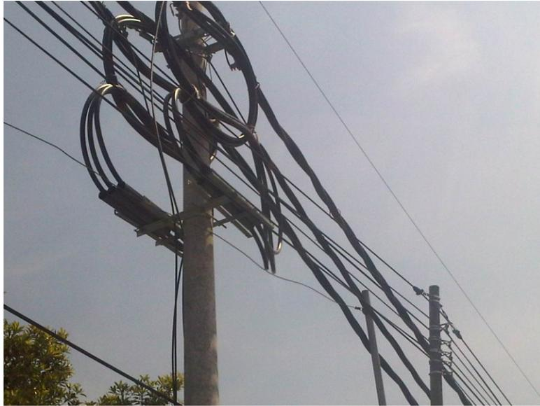
**Gambar 2.4** Saluran Kabel Udara Tegangan Menengah
