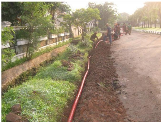
**Gambar 2.5** Saluran Kabel Tegangan Menengah
