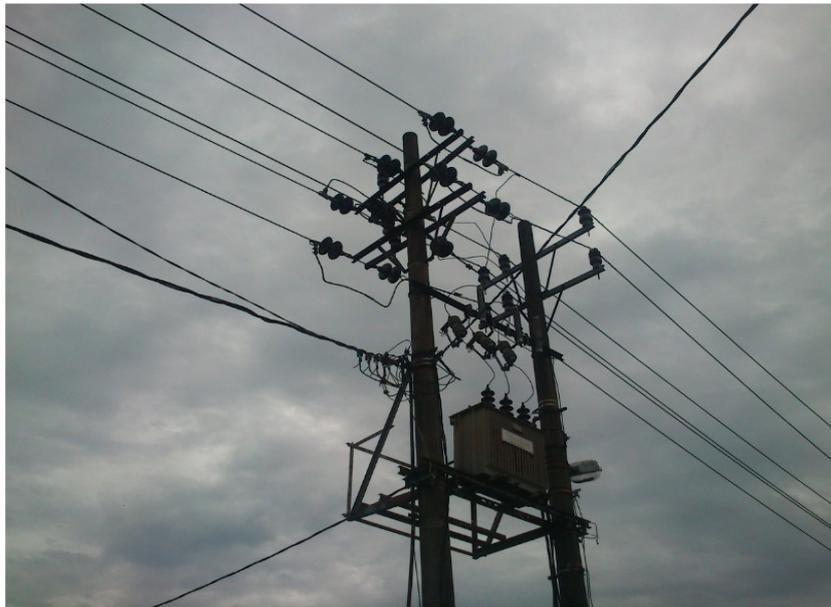
**Gambar 2.3** Saluran Kabel Udara Tegangan Menengah
