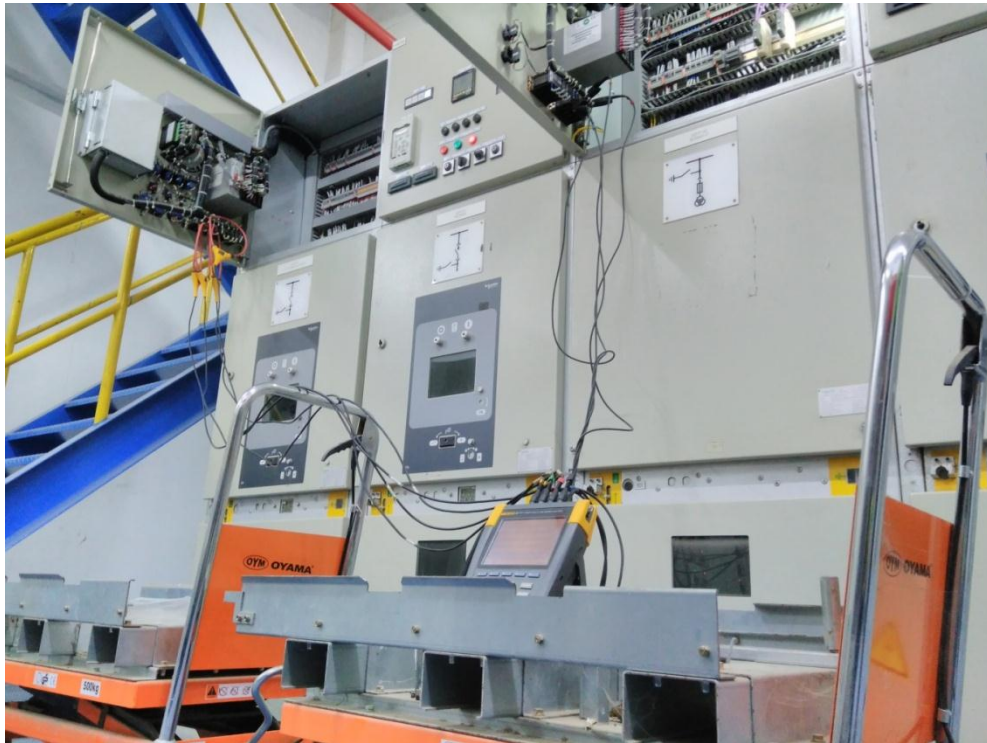
Gambar 4.2 Pengukuran pada masing-masing R, S, T
