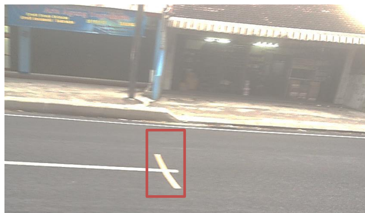
Gambar 3 Lakban yang digunakan sebagai alat bantu untuk melihat jarak tinjauan yaitu 50 meter.
