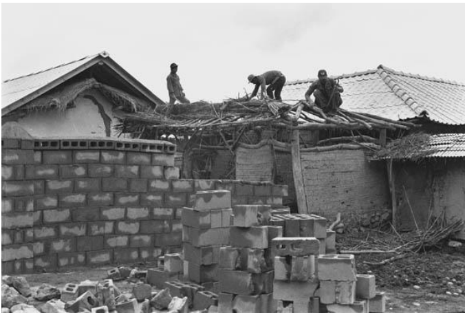
Gambar: Perbaikan atap rumah
