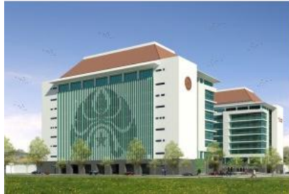
Gambar Pembangunan Gedung Universitas Malang
