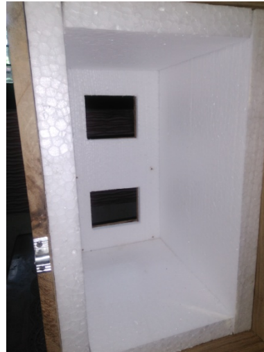
Gambar 3.16 Pemasangan lapisan Styrofoam
