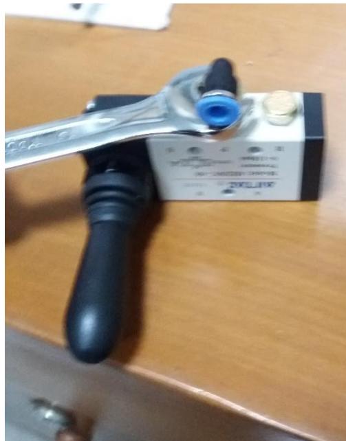
Gambar 4.21. pemasangan fitting ke hand control valve
