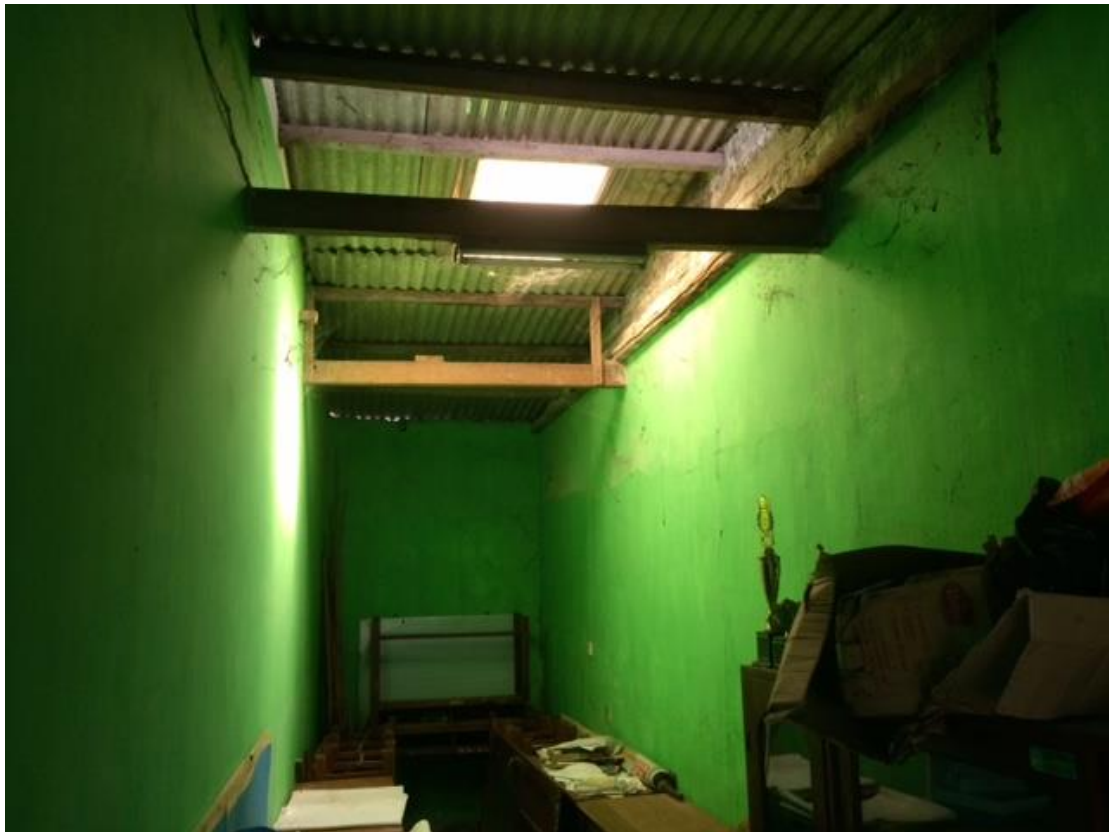
Gambar 1.2. Kondisi gudang sekolah yang belum terpasang plafon
