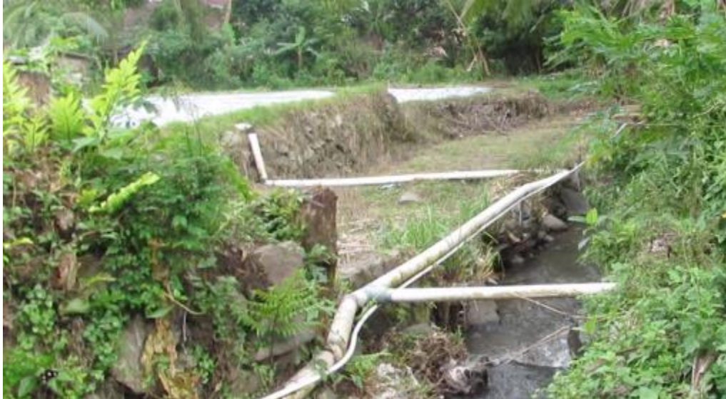
Gambar 4. Pipa saluran yang telah terpasang.
