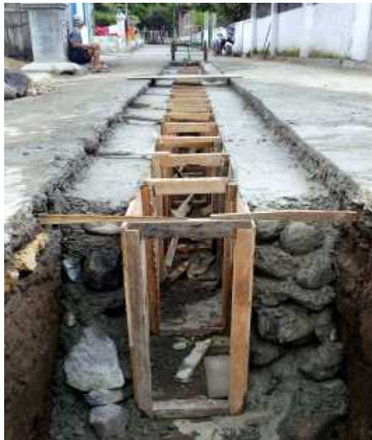
Gambar 2.6. Bagian dinding saluran yang telah terisi dengan pasangan batu kali
