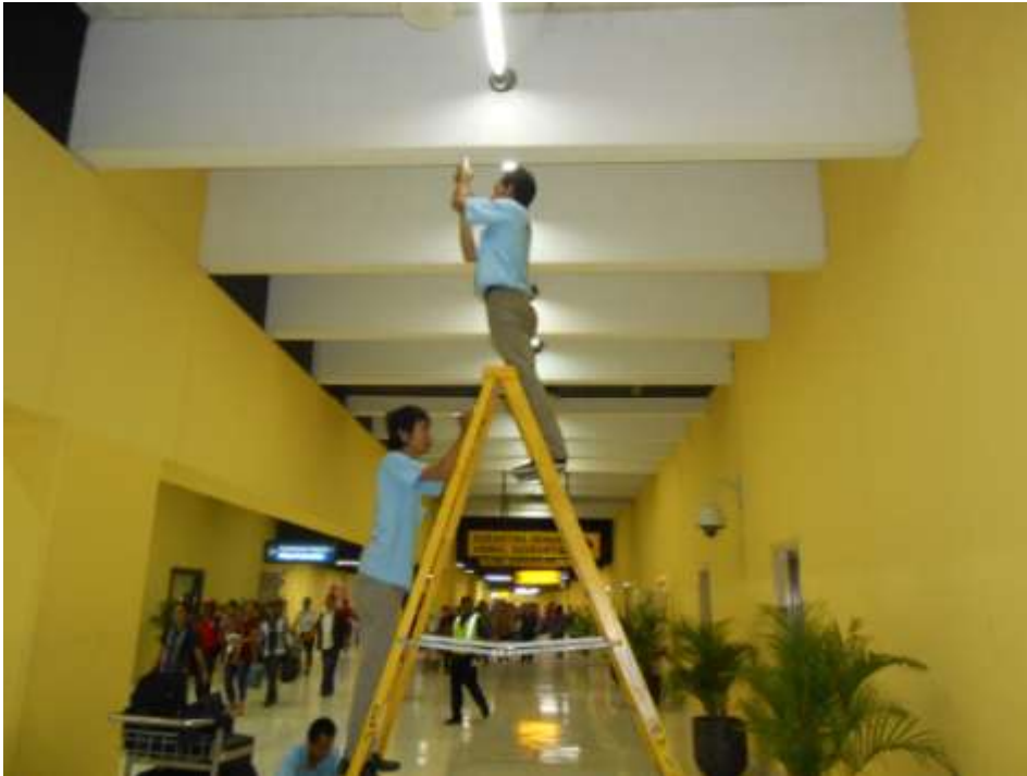
CC. UJI HAMMER TEST TERMINAL 1B SEBELAH KANAN AREA LOBBY KEDATANGAN
