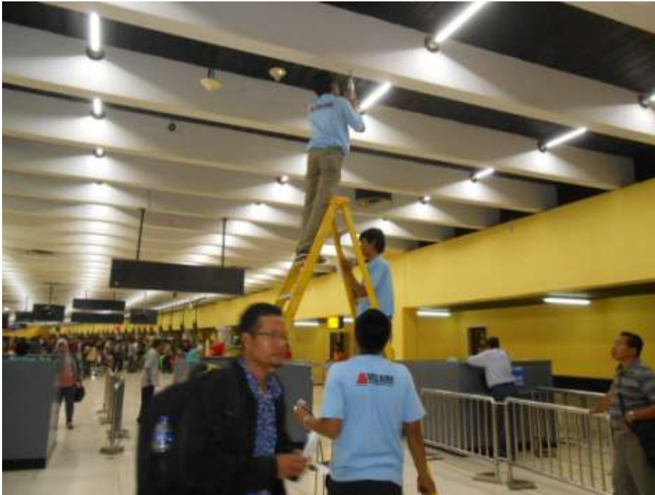
AA. UJI HAMMER TEST TERMINAL 1B SEBELAH KIRI AREA PSC
