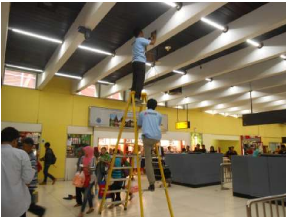
BB. UJI UPV TERMINAL 1B SEBELAH KIRI AREA PSC
