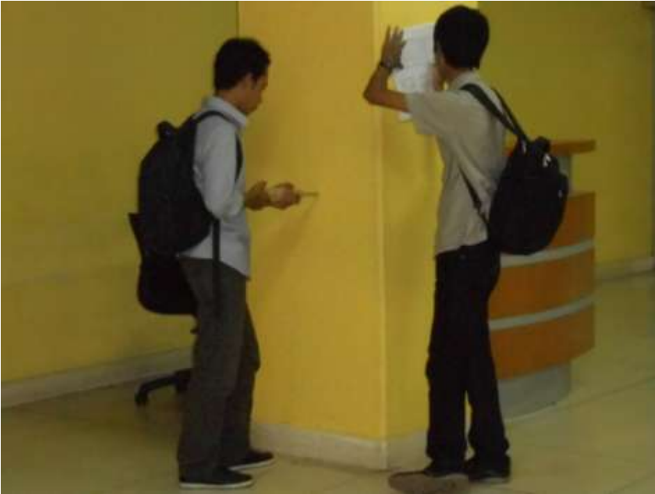
F. UJI HAMMER TEST TERMINAL 1C BAGIAN TENGAH LANTAI BAWAH AREA PSC
