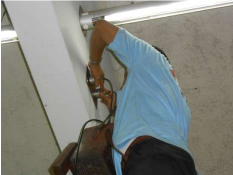
DD. UJI UPV TERMINAL 1B SEBELAH KANAN AREA LOBBY KEDATANGAN
