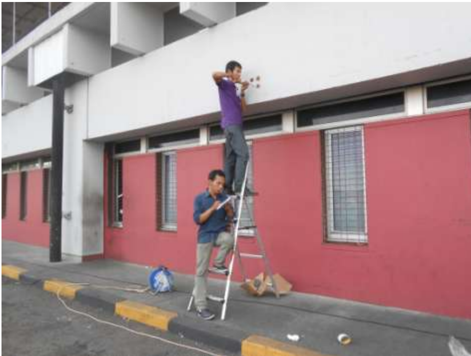
U. UJI HAMMER TEST TERMINAL 1A SEBELAH KANAN ANJUNGAN AREA BREAKDOWN
