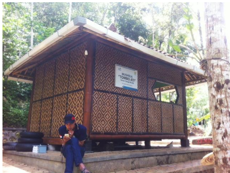
Gambar 3.2 Mushola “Tombo Ati” setelah dilakukan renovasi(1)
