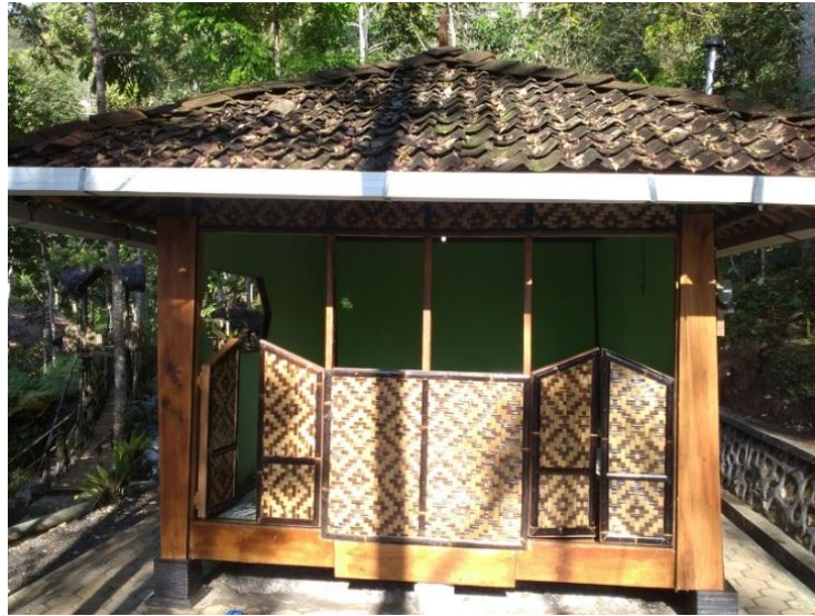
Gambar 3.3 Mushola “Tombo Ati” setelah dilakukan renovasi(2)
