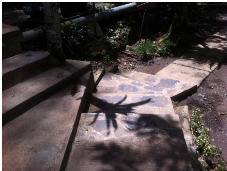
Gambar 3.6 Kondisi jalan setapak setelah dilakukan renovasi
