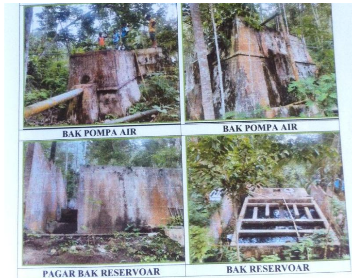
Gambar 3.4 Sarana air bersih sebelum direnovasi
