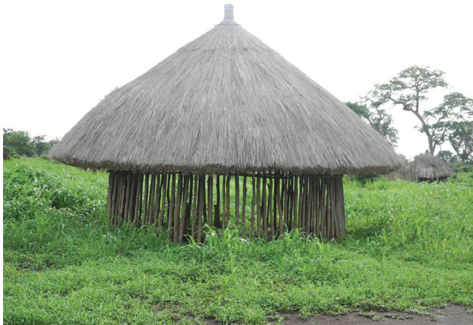
Gambar 7.1. Bangunan tukul (rumah) yang tidak layak di pemukiman baru di Gambella
