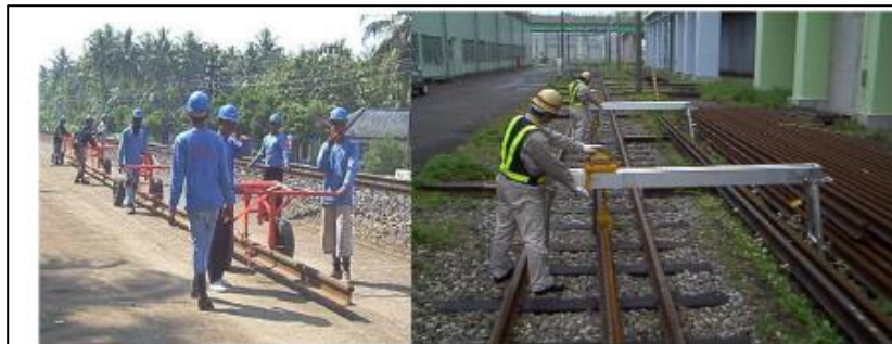
Gambar Error! No text of specified style in document..33 Pemasangan rel (Sumber : Laporan Proyek Pembangunan Jalur Kereta Api Ganda Antara Cicalengka-Cipeundeuy Lintas Bandung-Kroya )
