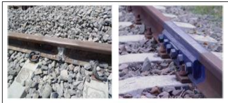
Gambar Error! No text of specified style in document..35 Hasil akhir pekerjaan peyambungan rel
