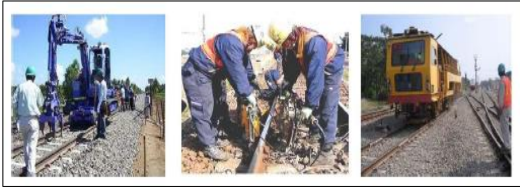
Gambar Error! No text of specified style in document..37 Pematatan upper ballast , pengecekan elevasi dan alinemen, dan pengecekan rel
