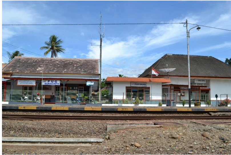
Gambar 5.8 Bangunan peron Stasiun Sukacinta eksisting (Sumber : PT. KAI Divre III Sumatera Selatan, 2015)
