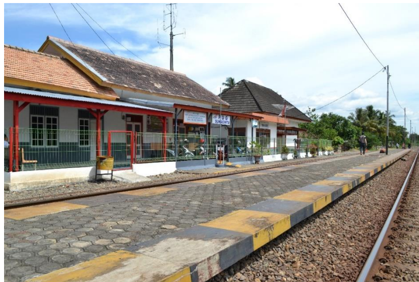
Gambar 5.9 Bangunan peron Stasiun Sukacinta eksisting (Sumber : PT. KAI Divre III Sumatera Selatan, 2015)
