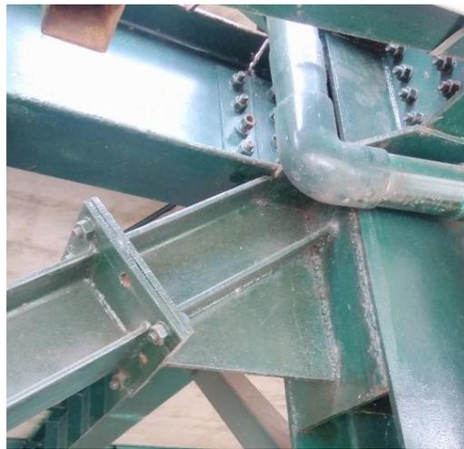
Gambar 4. 6 Simpul pada sambungan *bracing* bagian atas
