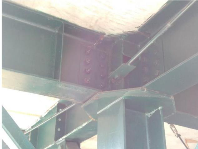
Gambar 4. 8 Simpul pada sambungan kolom dan balok baja
