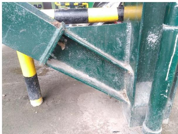
Gambar 4. 4 Simpul pada sambungan *bracing* bagian bawah
