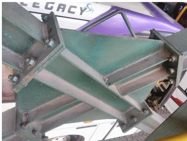
Gambar 4. 7 Simpul pada sambungan *bracing* tipe X
