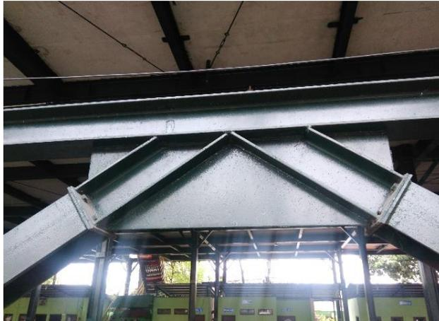
Gambar 4. 5 Simpul pada sambungan *bracing* tipe V terbalik dan K
