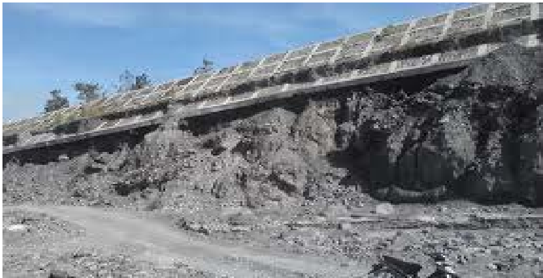
Gambar 5.5 Tampak lokasi penambangan pada titik 1 (sumber : Survey 2017 )
