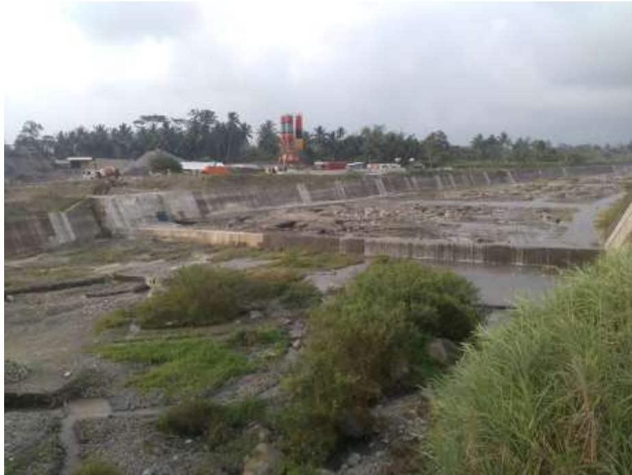
Gambar 5.3 Bangunan Pengendali Air Pada Desa Jumoyo
