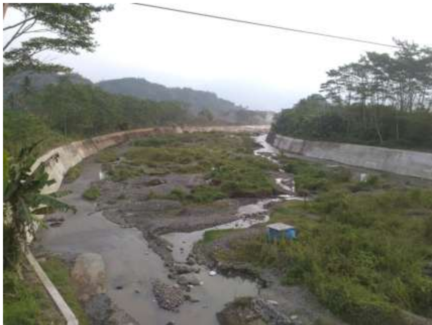
Gambar 5.2 Bangunan Pengendali Air Pada Desa Gulon
