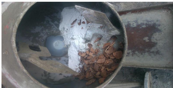
Gambar 4.24 Proses pencampuran beton dalam 1 adukan beton menggunakan concrete mixer
