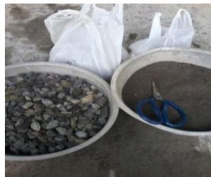
Gambar 4.23 Bahan pembuatan beton dalam 1 adukan
