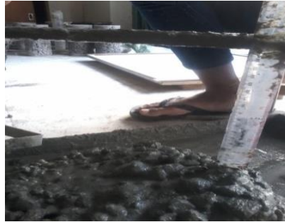
(a) Pengujian slump
