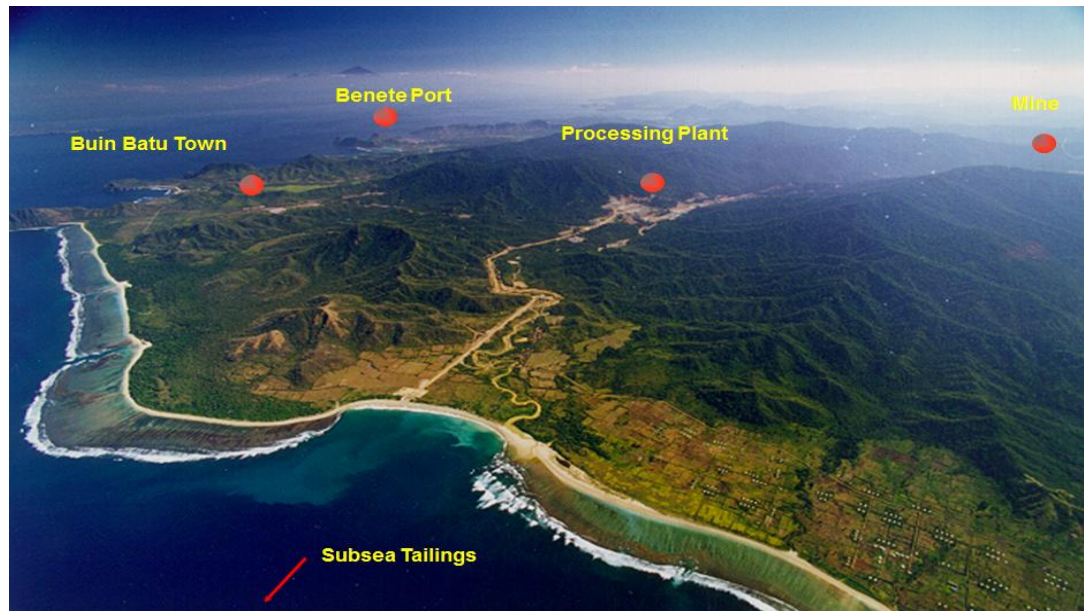
Gambar 6. Lokasi Proyek Batu Hijau
