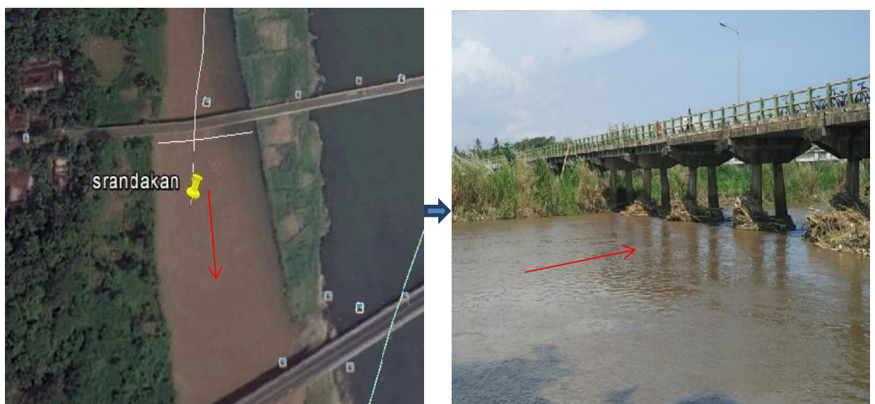
Gambar 4.3 Lokasi penelitian pada Jembatan Srandakan
