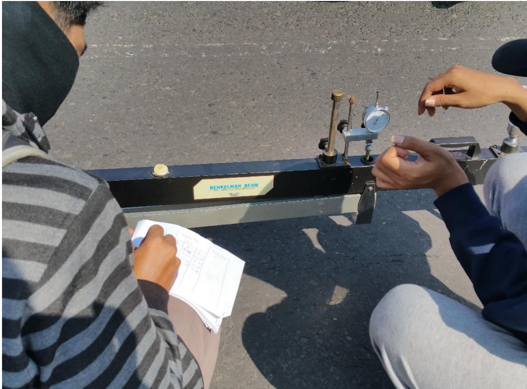
Gambar 4.4 Proses Pembacaan data pada arloji pengukur alat Benkelman Beam
