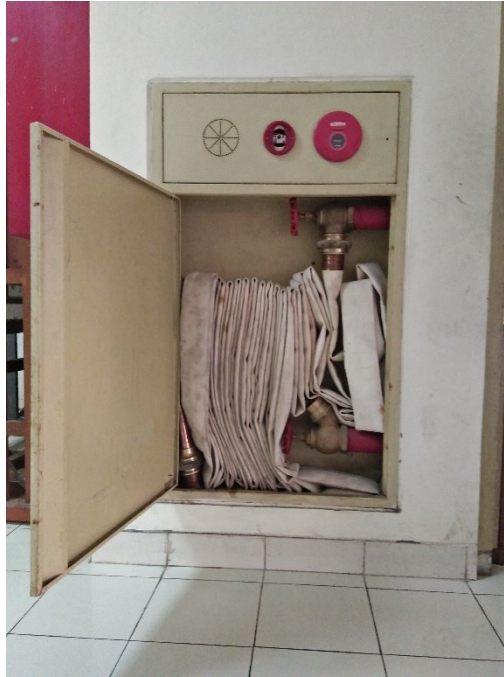
Gambar 5.10 Hidran Gedung
