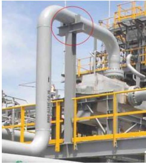
Gambar 2.31 Support pada pipa (Sugeng, 2014)
