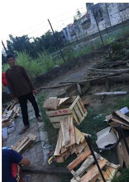
Pembuatan bak fitoremediasi
