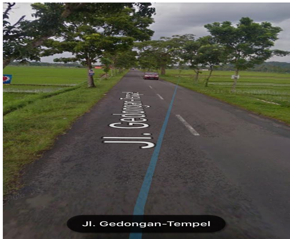
Gambar 4.7 Kondisi Ruas Jalan Gedongan-Tempel
