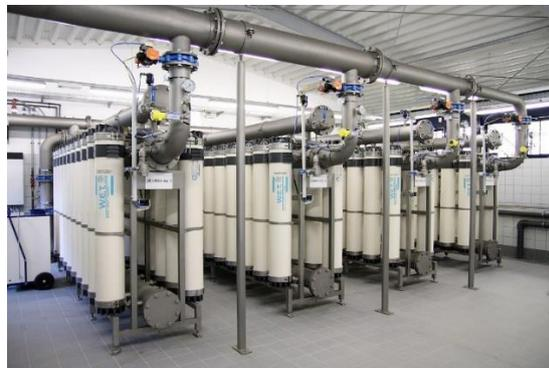
Gambar 3.1. Gambar Alat Ultrafiltrasi
