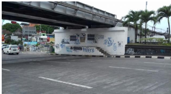
Lokasi jembatan Kewek arah ke kota Baru (Sumber : Dokumentasi Rini 2017)
