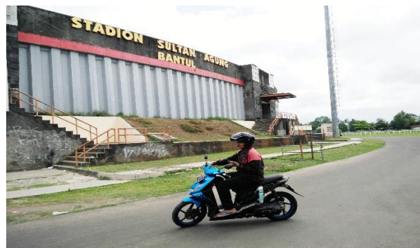
Gambar 3.68 posisi pengujian jalan
