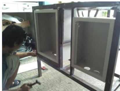
Gambar 4.44 Proses perakitan Box ke Kerangka
