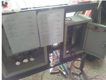
Gambar 4.45 Proses Perakitan PLC Dengan Elektro Pneumatik
