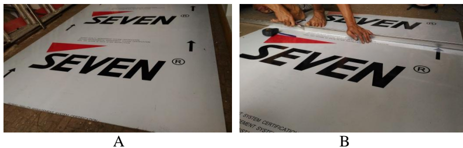
Gambar 4.56 A. Lembaran Plat ACP dan B. Proses Pemotongan Plat ACP
