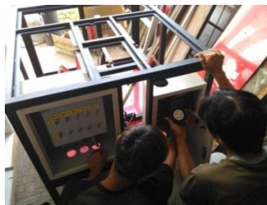
Gambar 4.52 Proses Perakitan Box Solenoid valve dan Box PLC
