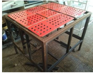
Gambar 4.38 Perakitan Plat Pelipat (ACP) dengan kerangka
