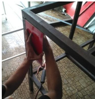
Gambar 4.26 Pembuatan dudukan plat ( ACP ) untuk Casing
