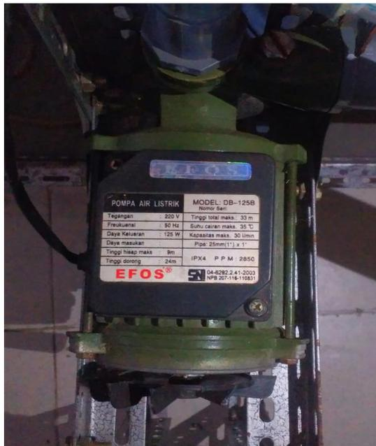
**Gambar 3.6** Pompa air
