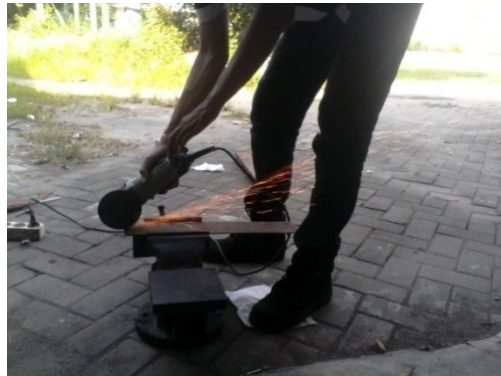
Gambar. 4.1. Pemotongan plat besi untuk dudukan motor listrik.
