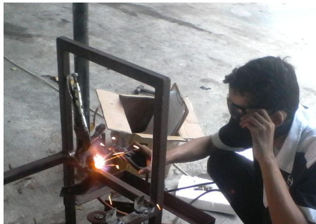
Gambar. 4.4. Pengelasan Braket pompa injeksi
