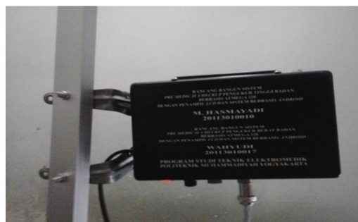
Gambar 4.6. Tampak box pada tiang
