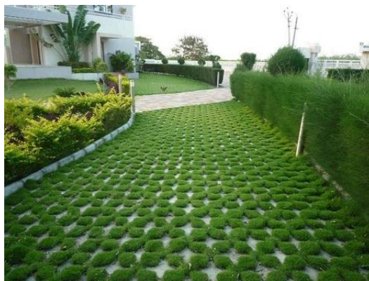
Gambar 3.7 Penerapan grass block pada carport
