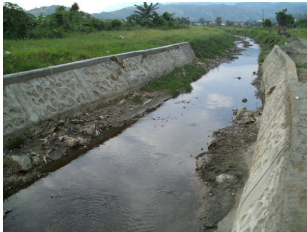
Gambar 3.6 Drainase saluran terbuka (sumber :
