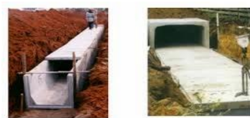
Gambar 3.5 Drainase saluran tertutup (sumbe : http://umarcivilengineering.blogspot.co.id/2015/02/drainase-perkotaan.html ).
